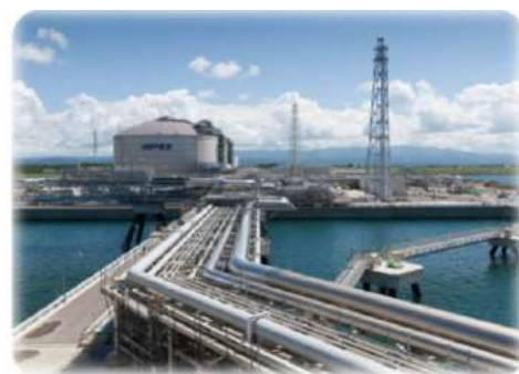
直江津 LNG 基地
