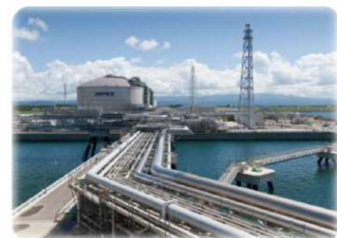
直江津 LNG 基地
