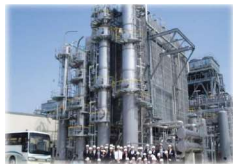
長岡 越路原プラント
